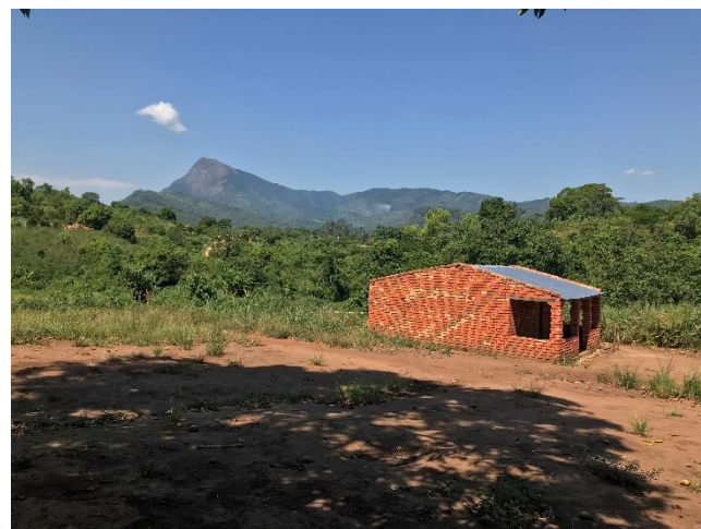
Figura 19 – Habitação com paredes blocos quimados e cobertura de chapa (resiliente) – Nangaze, 2021
