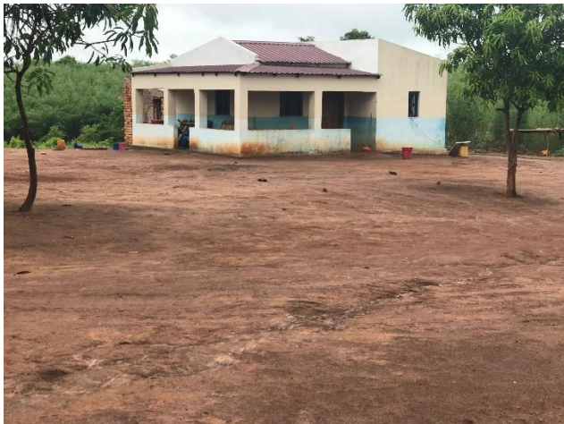
Figura 14 – Habitação com paredes de cimento e cobertura de chapa (muito resiliente) – Limbue, 2021
