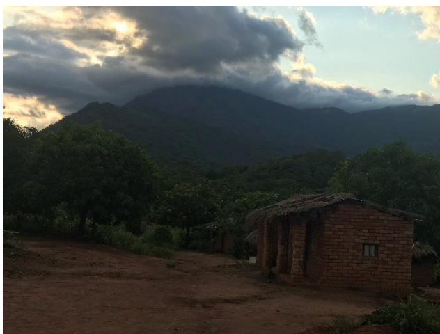
Figura 16 – Habitação com paredes blocos quimados e cobertura de palha (médio) – Nangaze, 2021
