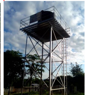
Figura.12.6. Fonte de Água operacional com tanque e painéis solares (Limbúé)
