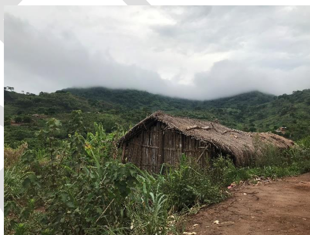
Figura 17 – Habitação com paredes de bambu e cobertura de palha (muito vulnerável) – Mucuera, 2021
